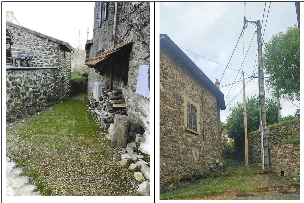
Chemin à désaffecter sur la partie Sud (photo de gauche)
